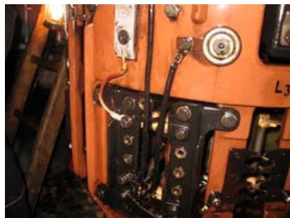
SLIKA 5 - Prikaz prakidačkog dela TRN nakon popravke
